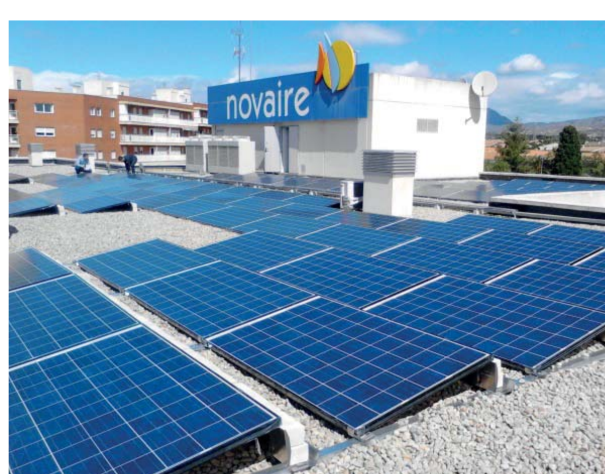
Instalación de módulos fotovoltaicos en NOVAIRE. OHL Servicios.
