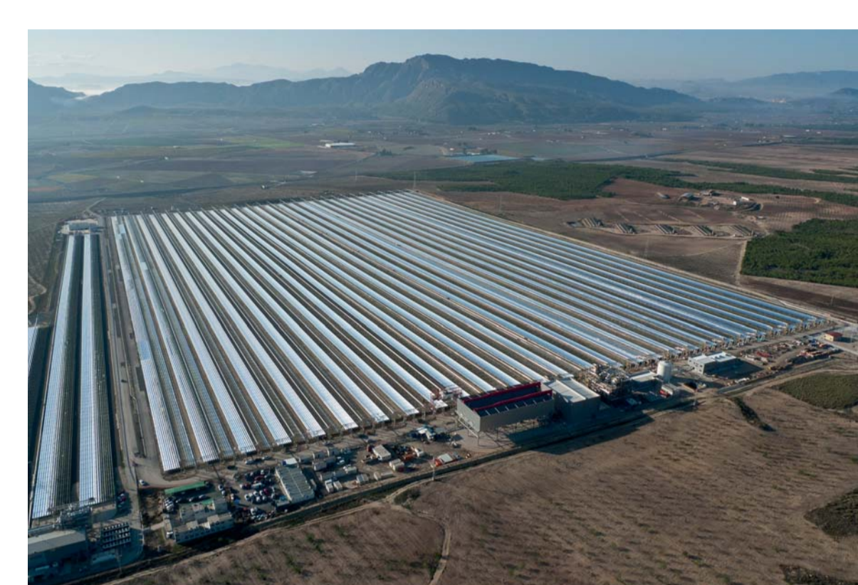
Plantar termosolar 30 MW Puerto Errado 2. Murcia. OHL Industrial.
